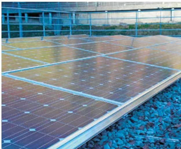
Bild 4 Solaranlage auf Flachdach mit umlaufendem permanentem Geländer
