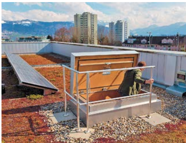
Bild 10 Gebäudeinterner Treppenaufgang
