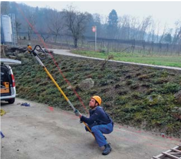
Bild 17 Seilwurfsystem mit Industrieschleuder
